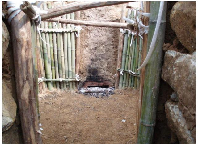
耐火煉瓦を積み上げて煙道を整備する。完成後はたき火をして乾燥させる。
