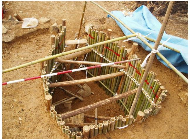
窯壁は竹で大まかな形に組んだ後、外側に練り土を埋め戻して締め固める。
