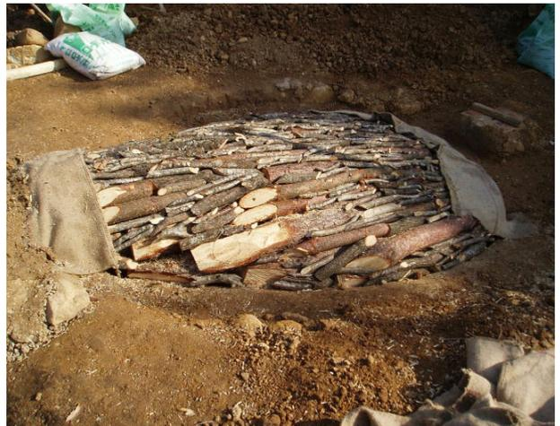
切り子、端材を置いて窯屋根の形に整える。
